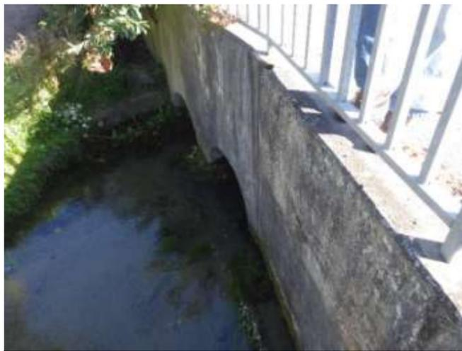
OH94, passages busés sous dimensionnées diamètre 1,20m sous la rocade
