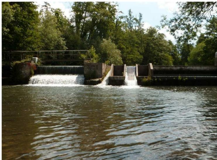
Aval du barrage William (de droite à gauche : clapet, passe à canoë, passe à poisson et clapet) – source SF Onema
