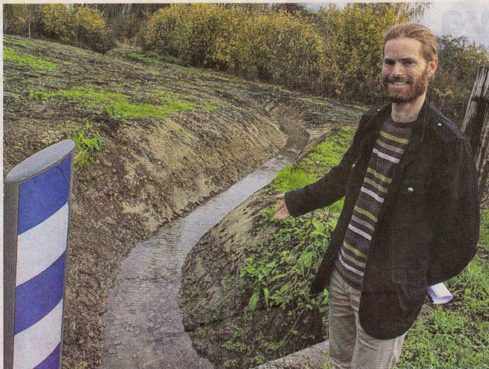
Thomas Dupuis, technicien du Syndicat intercommunal de la basse vallée de la Risle, a supervisé les travaux qui ont permis au ruisseau des échaudés de couler normalement à nouveau.
