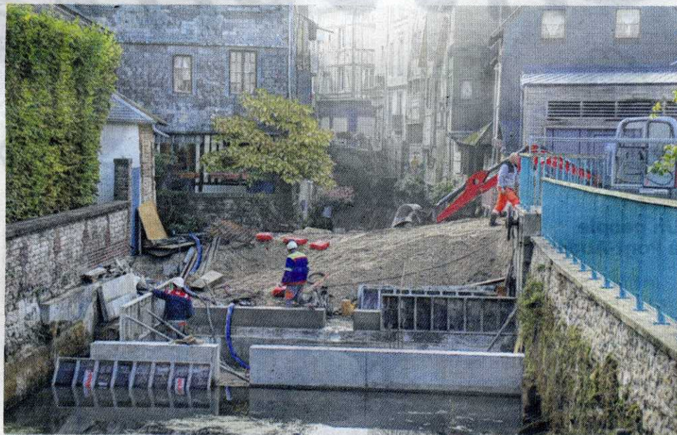
Deux seuils et une rampe à anguilles sont en cours d'installation place Louis-Gillain.
