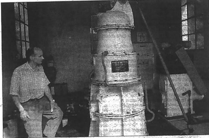
Benoît Colliard a hérité de la turbine de son père au Pont-Joly. Cette installation était l'une des toutes premières à produire de l'électricité, à la fin du 19ème siècle.
