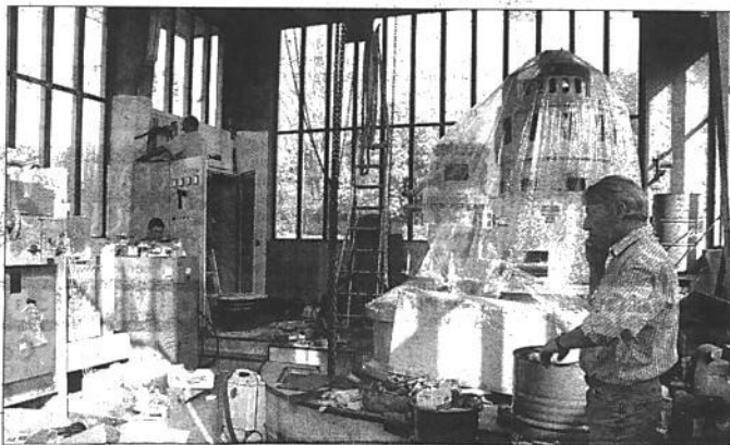
Richard Rodier a acquis le barrage de la Madeleine à Pont-Audemer et est en train de restaurer l'ensemble des installations mécaniques et électriques.
