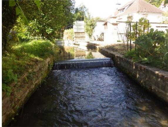
Ouvrage CE2 25 : Suppression du seuil de fortune (blocs, poteau béton électrique) Chute inférieure à 0.1 m (Brionne).
