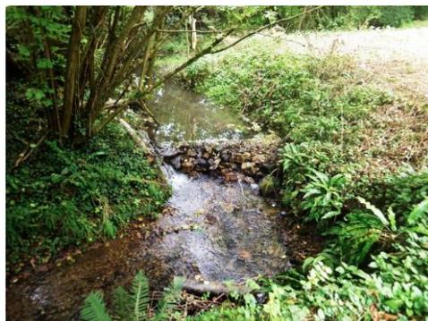
Ouvrage CE2 18 : Travaux de suppression de 2 seuils successifs. Hauteur inférieure à 0.15 m (Freneuse sur Risle)
