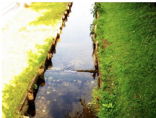
Ouvrage CE2 21 : Suppression du seuil (poutrelle/pieux). Hauteur inférieure à 0.1 m (Freneuse sur Risle)
