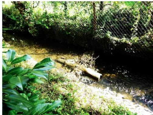
Ouvrage CE2 13 : Travaux de suppression des 3 seuils inférieurs à 0.2 m chacun (Condé sur Risle)
