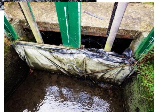
Ouvrage CE2 27 : Travaux de franchissement du seuil du pont SNCF (rétrécissement du cours d'eau et seuil inférieur). Chute inférieure à 0,1 m (Fontaine la Soret)
