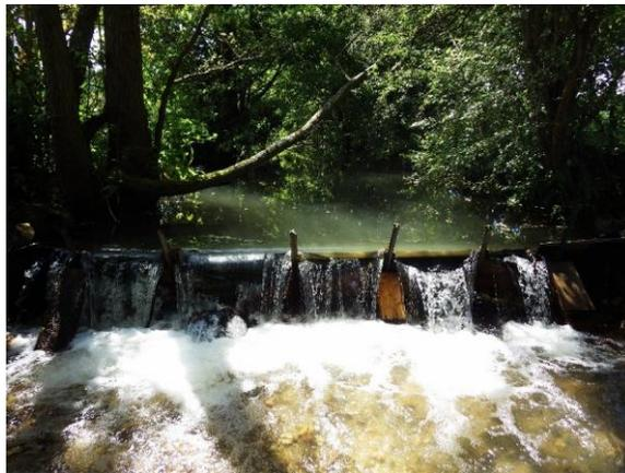
Ouvrage CE2 05 : Etude et travaux OH/ROE sur 2 seuils résiduels pour recouvrer un écoulement dynamique en amont. Hauteur de chute inférieure à 0.4 m pour les bras droit et gauche (Brionne)
