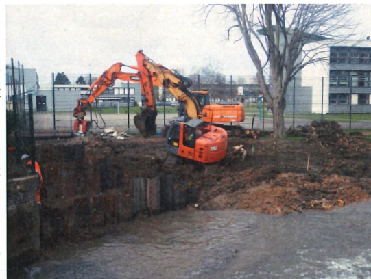
Pendant les travaux, mars 2017
