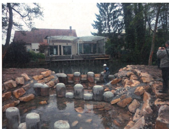
Jour, mise en eau de l'aménagement, mai 2017
