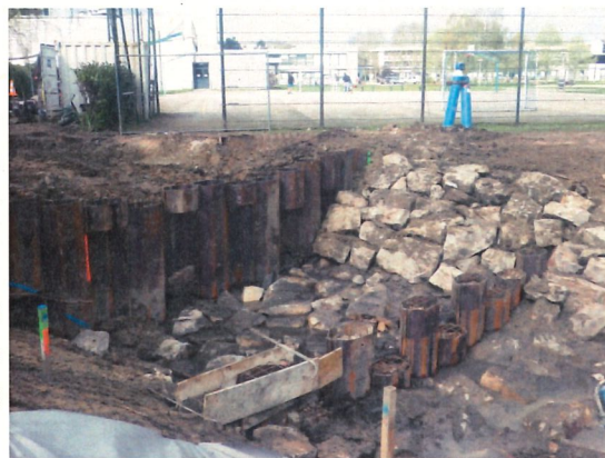
Pendant les travaux, seuil palplanche en mars 2017
