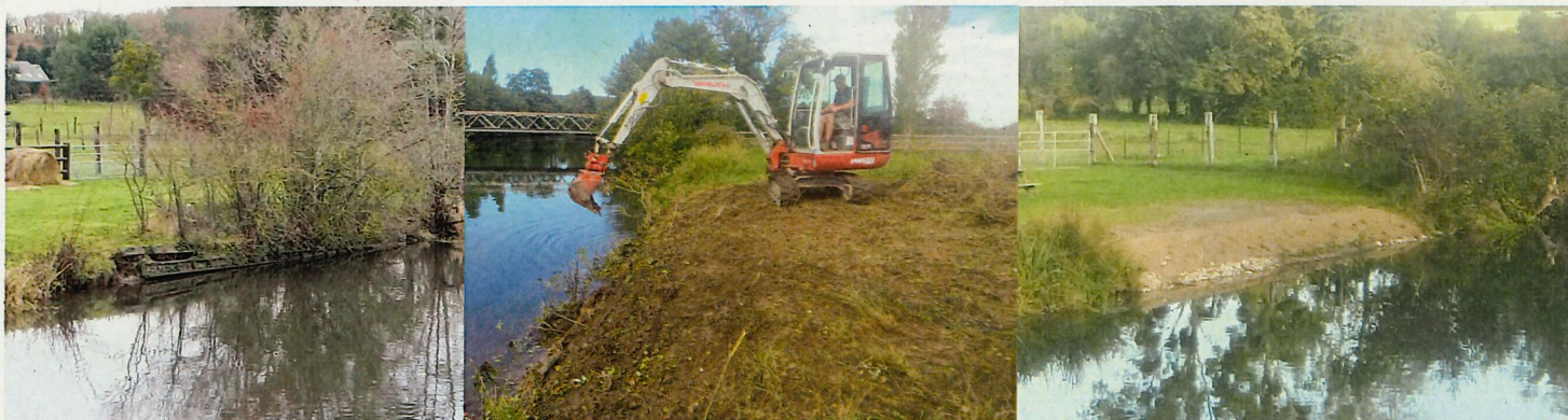
Site de Glos-sur-Risle (avant/pendant/après travaux)
