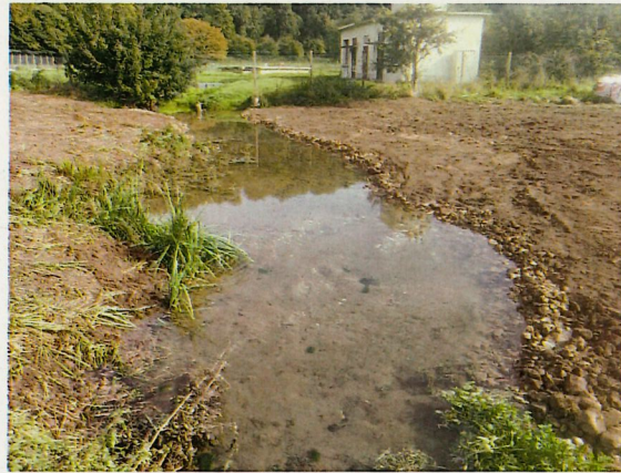
Site au niveau des sources du Clérot (avant/après travaux) - resserrement par risberme et par épis
